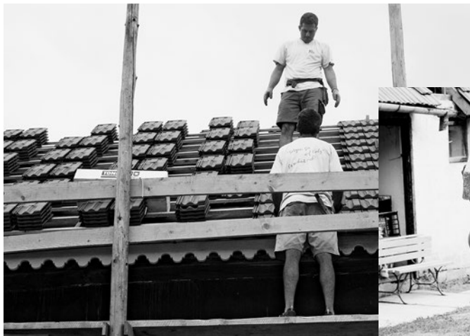
Sanierung des Daches
